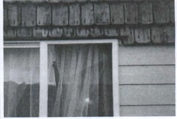
Fotografía N° 6: Marco de la ventana sin sello ni remate con revestimiento de muro, fachada sur.
