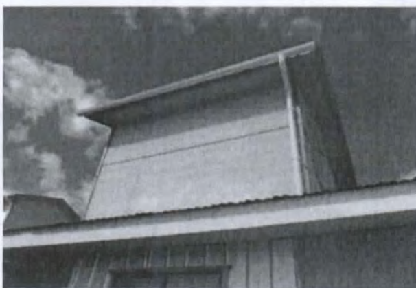
Fotografía N° 40: Revestimiento exterior de fibrocemento.
