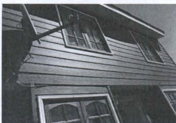
Fotografía N° 87: Modificación al proyecto.
