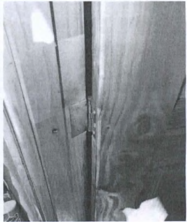
Fotografía N° 23: Bisagras mal instaladas en la puerta de cocina.
