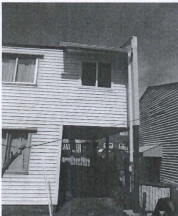
Fotografía N° 32: Bajada de agua corta en fachada norte.
