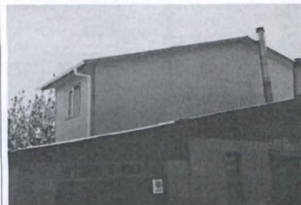
Fotografía N° 54: Ampliación sin el muro cortafuego proyectado en el pareo.
