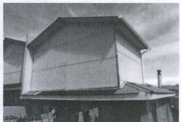
Fotografía N° 41: Revestimiento exterior de fibrocemento.
