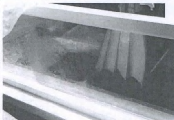
Fotografía N° 61: Hoja de la ventana del segundo piso, de menor tamaño que el marco.
