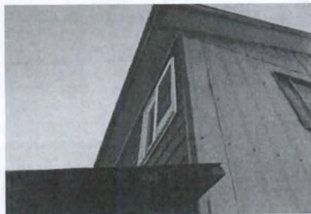
Fotografía N° 7: Fachada oriente sin intervención
