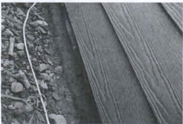
Fotografía N° 88: Revestimiento anterior sin retirar
