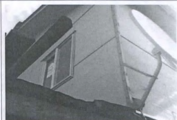
Fotografía N° 45: Revestimiento exterior de fibrocemento en zona ampliada.
