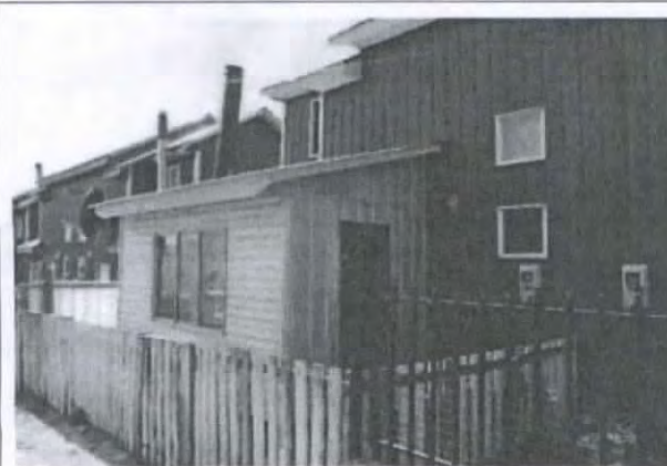
Fotografía N° 44: Ampliación en antejardín no graficada en los planos.
