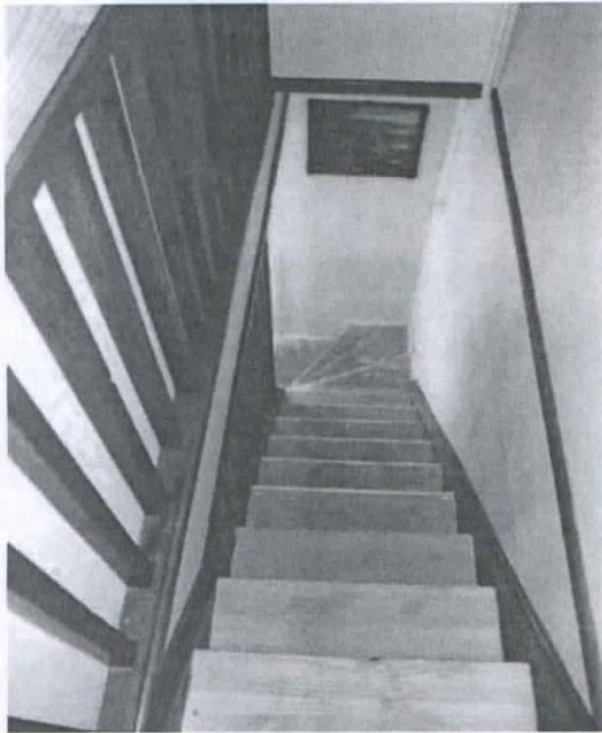
Fotografía N° 42: Escalera de madera de pino radiata.
