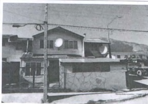
Fotografía N° 10: Ampliación en antejardín no graficada en planos.
