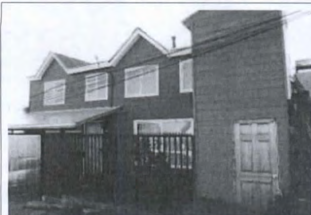
Fotografía N° 64: Fachada poniente con ampliaciones y modificaciones no graficadas en los planos del proyecto.
