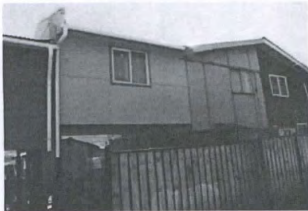
Fotografía N° 50: Revestimiento exterior de fibrocemento en ampliación.
