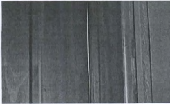
Fotografía N° 72: Cielo de vivienda
