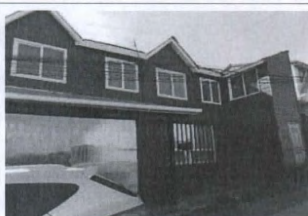
Fotografía N° 65: Fachada poniente con ampliaciones y modificaciones no graficadas en los planos del proyecto.
