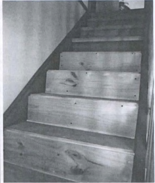
Fotografía N° 43: Escalera de madera de pino radiata.
