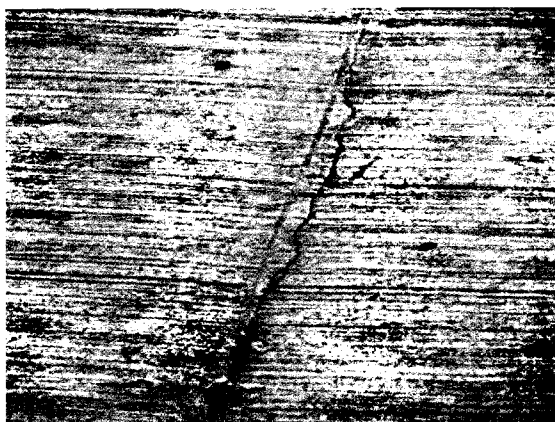
Fotografía N° 19 – 4/03/2015: Aserrado de Junta no coincide con fisura inducida en calle Eusebio Lillo
