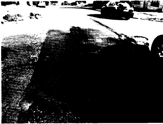
Fotografía N° 25 – 6/03/2015: Reparación de baches de calle Almirante Simpson.
