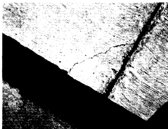
Fotografía N° 12 – 06/03/2015: Fisuras en zarpa de hormigón en calle Francisco Bilbao entre Alejandro Gutiérrez y Alfonso Serrano.
